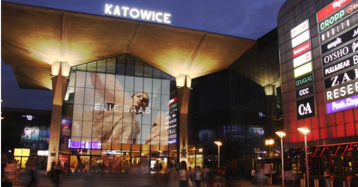
Katowice | Dworzec PKP
